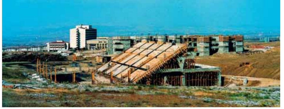
Merkez Spor Salonu inşaatı (1987)
