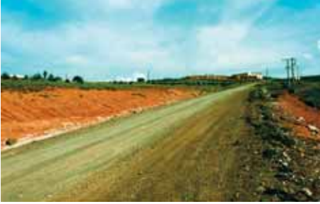
İlk inşaat çalışmaları (1982)
